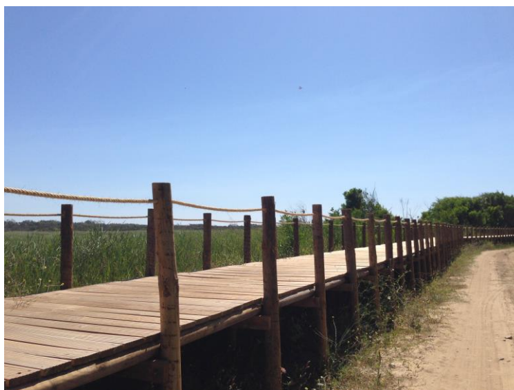
Foto 1 - Exemplo de passadiço em madeira com guarda em corda de sisal
